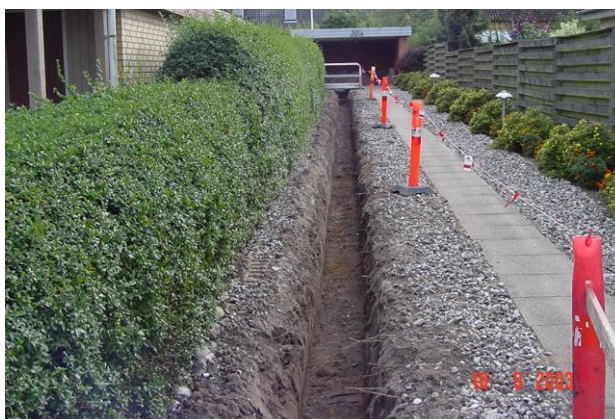
Jord og belægningssten langs udgravning er fjernet af hensyn til adgangsforholdene.
