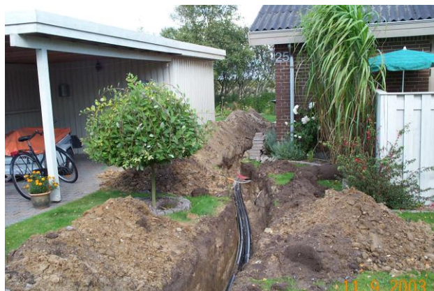
Jord og belægningssten langs renden fjernes i takt med opgravningen
