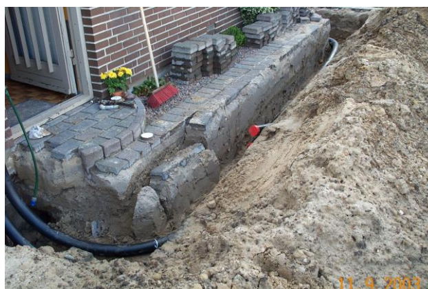
Jord ud for indgangsparti forhindrer udlægning af gangbro og belægningssten ligger for tæt på renden.
